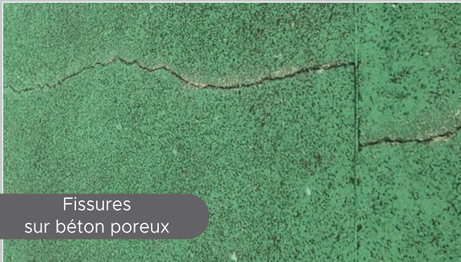
Décalage de sections sur béton poreux
